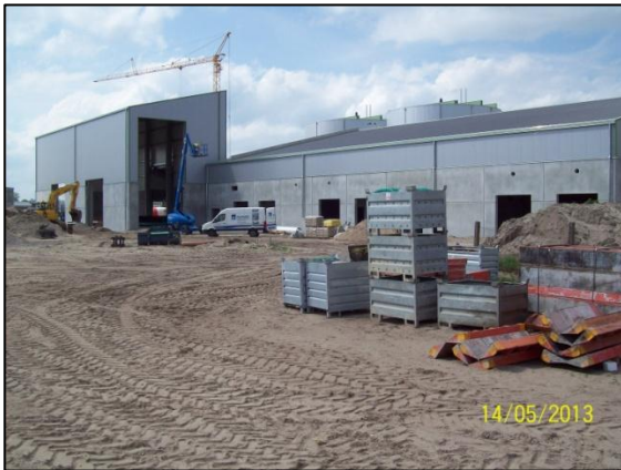
Bild 4: Annahmehalle (links) und Technikgebäude (rechts, Südseite), im Hintergrund Fermenter
